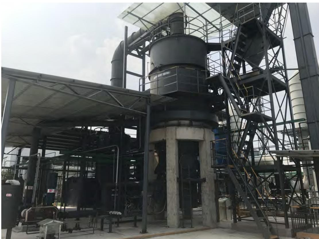
(循环流化床焚烧炉)
